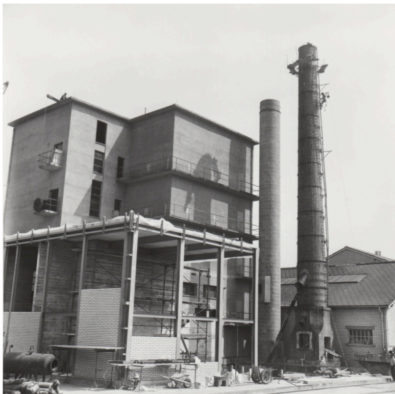
Démolition de l'ancienne cheminée – une des trois nouvelles cheminées est déjà présente – archives « grenier » ateliers CFF Yverdon.
